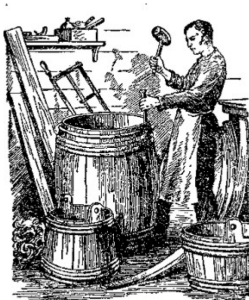
Figura 109. Acercando los zunchos a la parte más ancha del tonel se consigue rodearlo fuertemente
